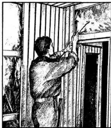
2-й этап. Установка горизонтального каркаса из бруса меньшего сечения
